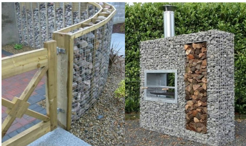
Fig. 3: a) cerco y b) parrilla contruidos con clastos de basalto.
