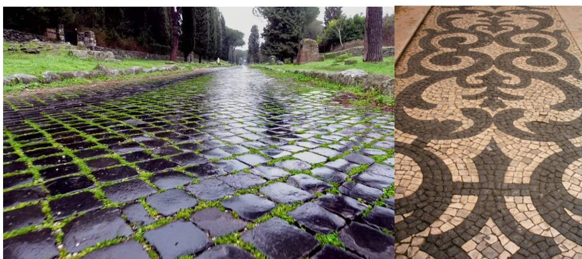
Fig. 4: a) calzada de adoquines y b) piso de adoquines de basalto (negros) y caliza (blancos).
