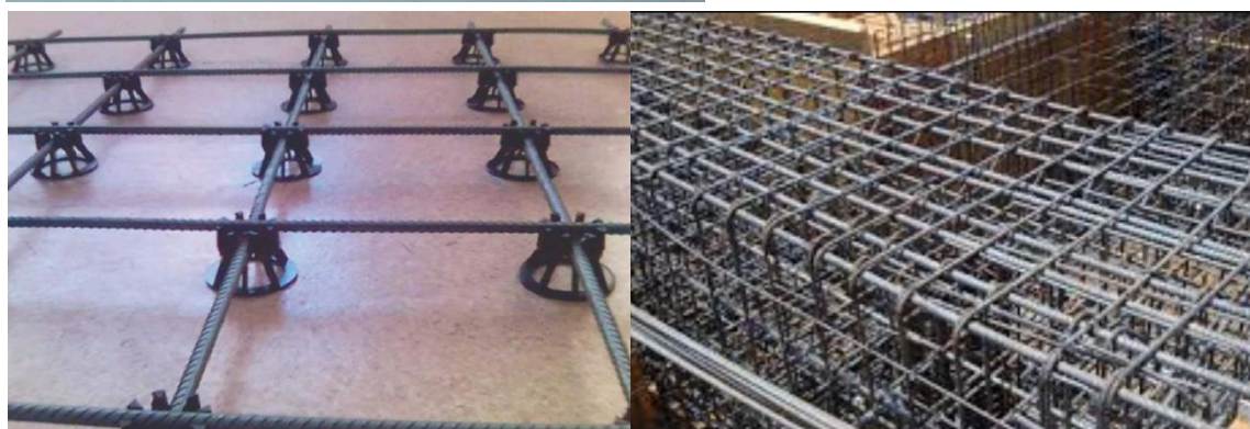
Fig. 12: barras corrugadas de basalto.
